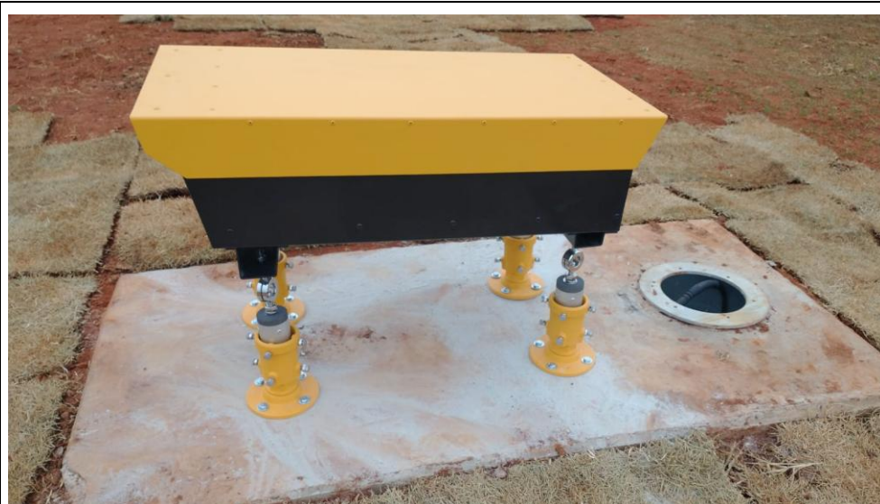
AEROPORTO DE SÃO PAULO/CONGONHAS PAPI PRECISION APPROACH PATH INDICATOR "INDICADOR DE TRAJETÓRIA DE APROXIMAÇÃO DE PRECISÃO"
