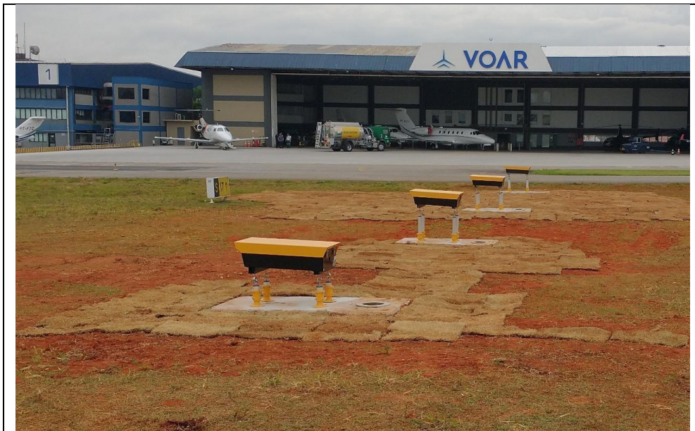
AEROPORTO DE SÃO PAULO/CONGONHAS PAPI PRECISION APPROACH PATH INDICATOR "INDICADOR DE TRAJETÓRIA DE APROXIMAÇÃO DE PRECISÃO"
